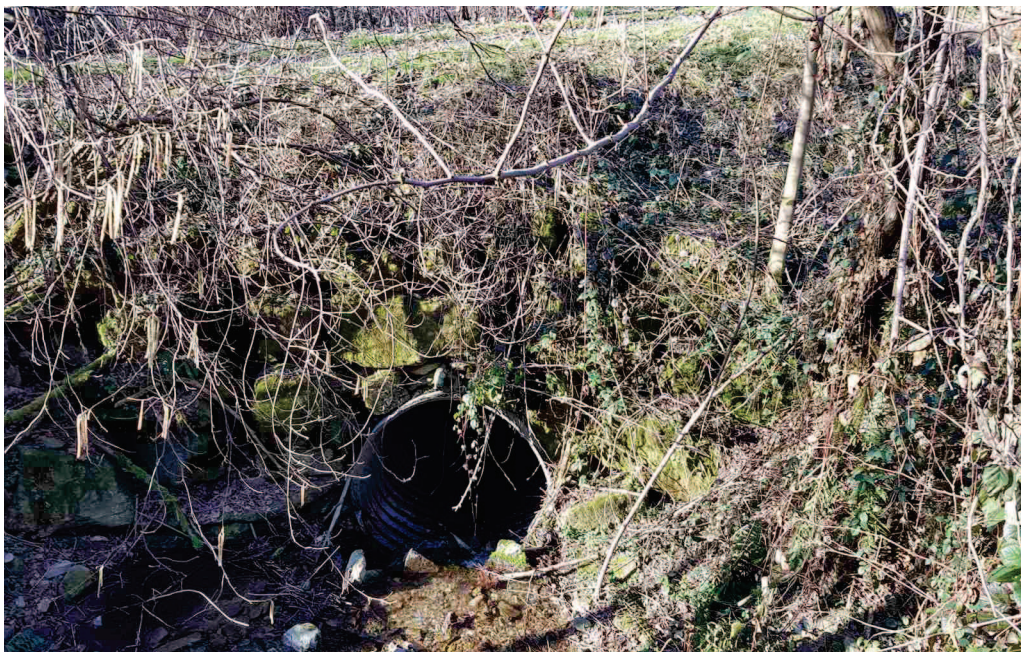
Fig. 1: Tubazione in acciaio ondulato su Via Chiabrera per attraversamento del Rio Traversere – Vista da monte verso valle. Codice opera AG-01
