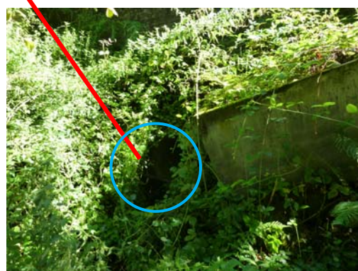
Terminale condotta interrata c.le Combetta, Øi 1.000 mm
