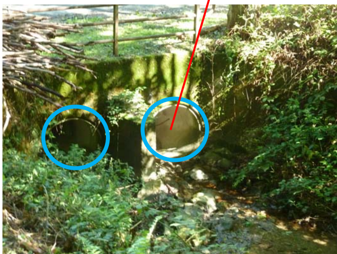
Sottopasso idraulico c.le Folatera, strada per S. Antonio. Doppio tubo Øi 800 mm
