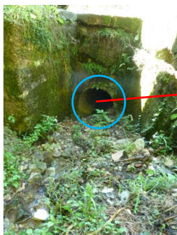
Testata condotta interrata c.le Combetta, tubazione Øi 1.000 mm
